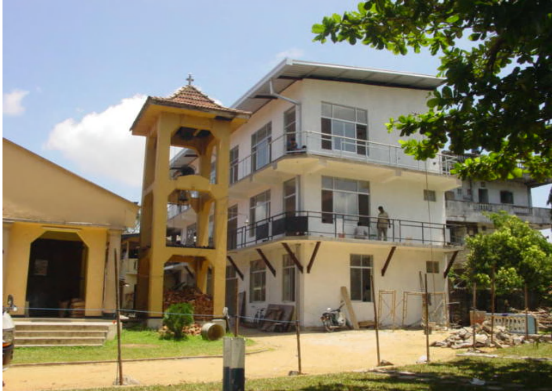
Het Dienstencentrum is Sedawatta, gebouwd in 2008.
